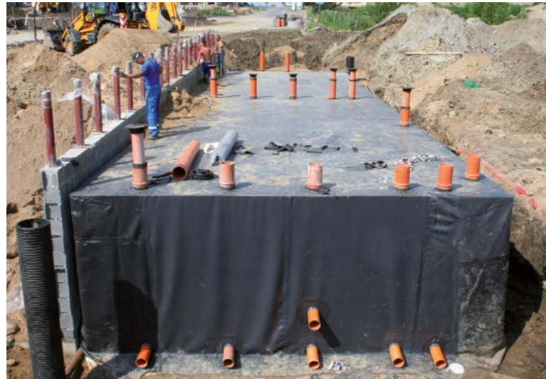
... als Zwischenspeicher im Regenwassersystem
