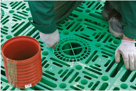
Entfernen des Frontgitters an der Oberseite der Stormbox für ein DN 200 Rohr mittels Cutter
